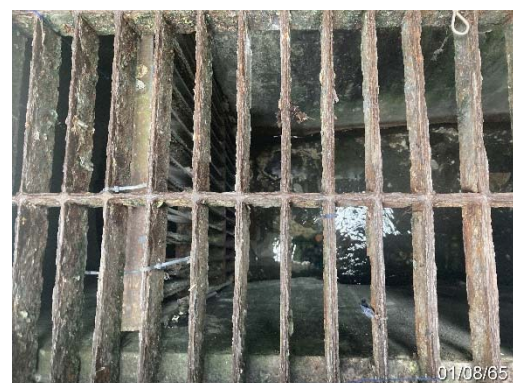
ตะแกรงดักขยะก่อนระบายออก
